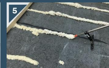
5 下地から少し浮かした状態で表面をなぞるように塗布します。その後、断熱材を押し当てるように敷設します。
